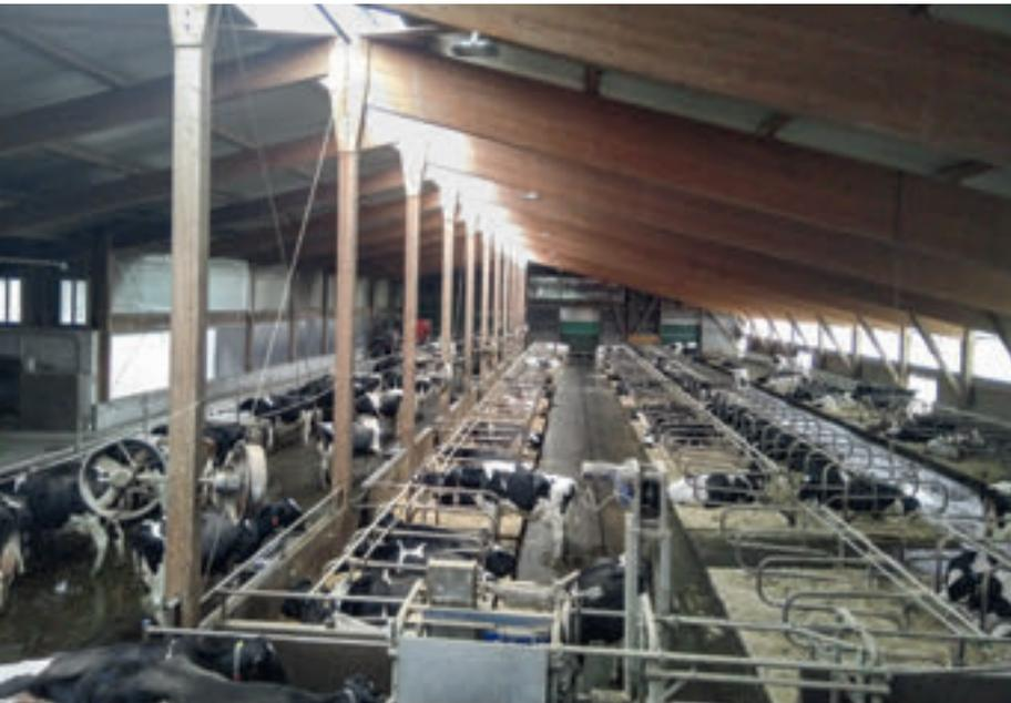
Bei einem Stall mit Querbelüftung sorgen kleine Axialventilatoren für eine gleichmässige Luftbewegung in der Nähe der Futterkrippe.
