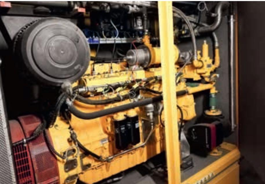
Das neue Blockheizkraftwerk liefert aus dem Biogas Strom und Wärme.
