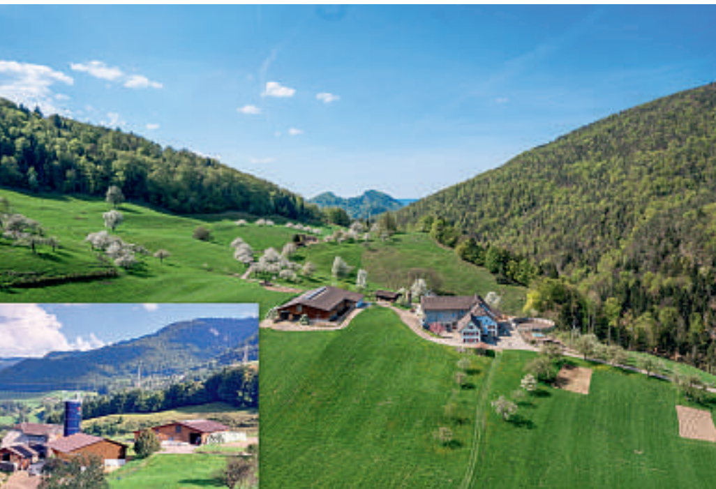
La ferme Girlang : l'année dernière, un nouveau hangar avec une installation PVC et un grenier ainsi qu'un silo-tour ont été construits.
