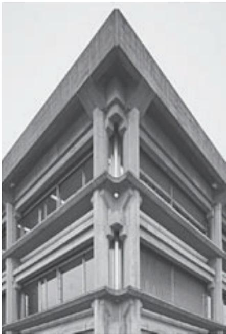
Die Gebäudeecke zeigt wie alles gefügt und getragen wird und lässt erkennen, dass die Fensterfront als Haut innen an den Stützen verläuft.
